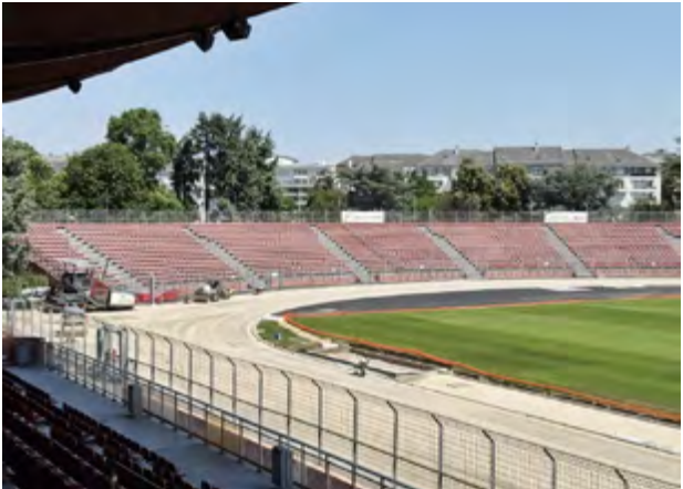
Photo du stade en cours de rénovation
